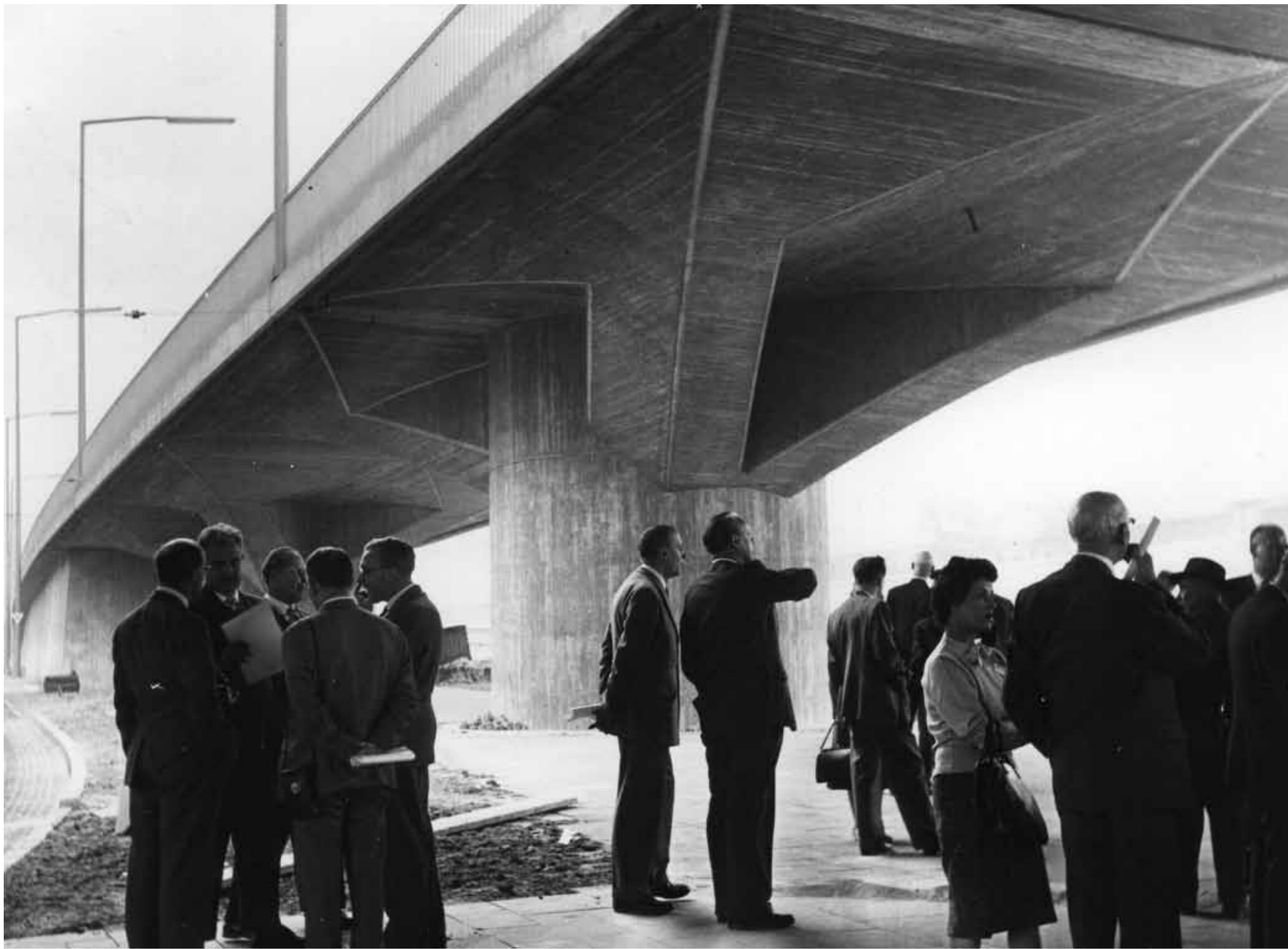
Britische Baufachleute besichtigen den Rheinbrückenkopf und die Hochstraße, 16.10.1959
